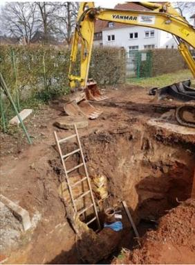
Hierbei wurde festgestellt, dass die Rohre, die parallel zur Zuwegung vor dem Pfarrhaus im Boden liegen, in einem sehr schlechten Zustand sind und dringend erneuert werden müssen. Aus diesem Grund war es notwendig, diesen Bereich auszubaggern und neue Rohre zu verlegen. Dies konnte nur durch das Entfernen der Hecke inclusive des eingewachsenen Zauns ermöglicht werden.
